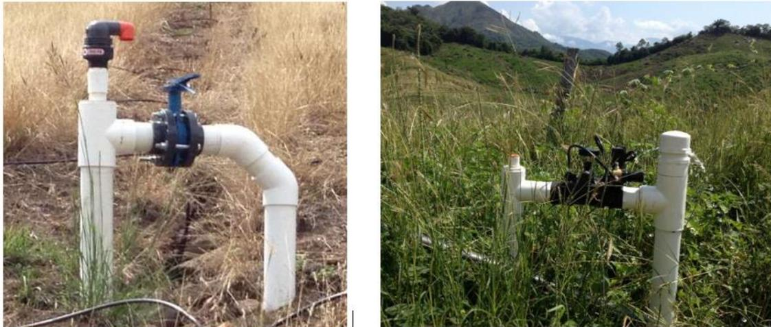
Fig 5. Módulo de control de riego y válvulas reguladoras de presión.
