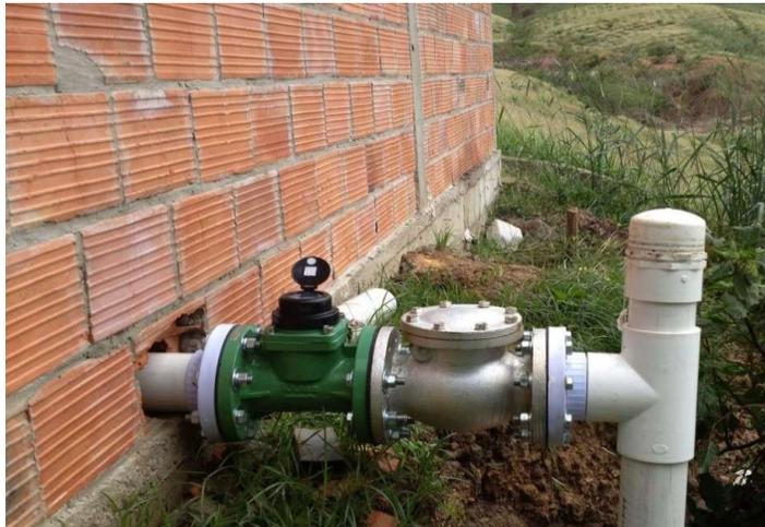
Fig.3 Contador volumétrico para el control del agua utilizada por el sistema de riego.
