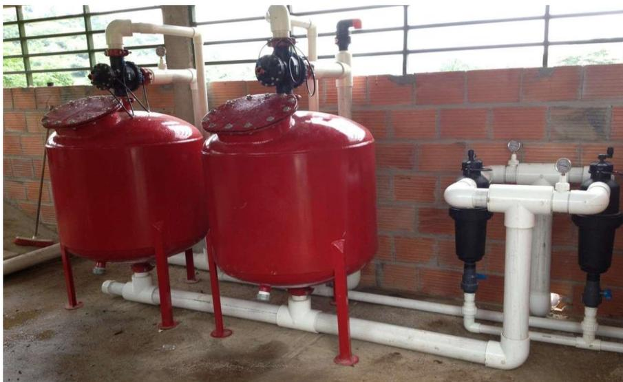
Fig 2. Estación de filtrado con filtros de arena y malla semiautomáticos.
